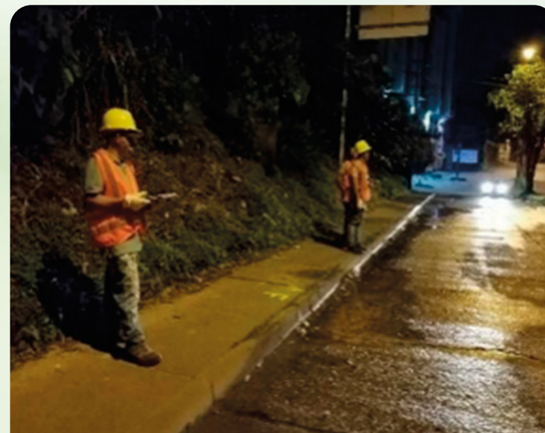
Intervención de fugas no visibles
