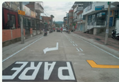
Calle 69 entre Carreras 25 y 26
