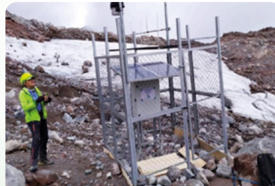
Estación hidroclimatológica Nevado Santa Isabel
