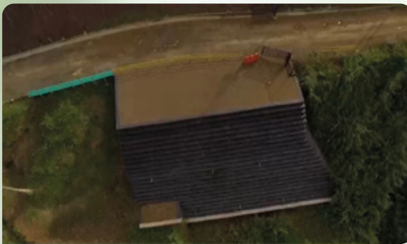
Reparación vía a la Planta de Tratamiento sector Canceles
